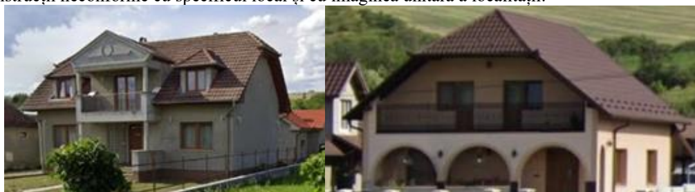
Figura 15- Construcții neconforme cu specificul local
